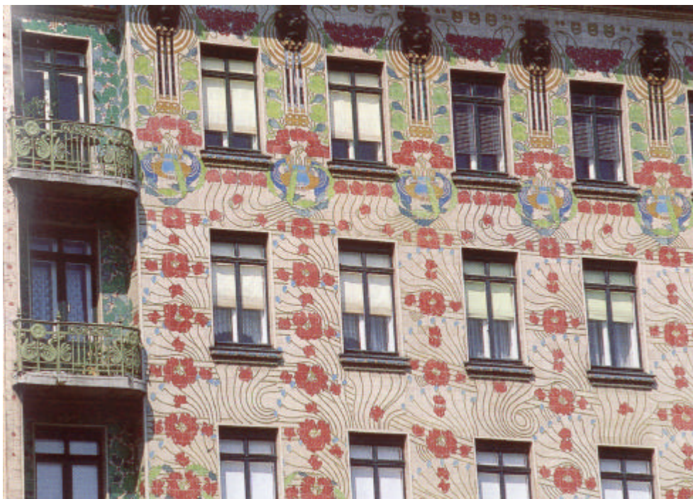
FIG. 31.- La Casa de las Mayólicas.(1889). Otto Wagner. Viena.
