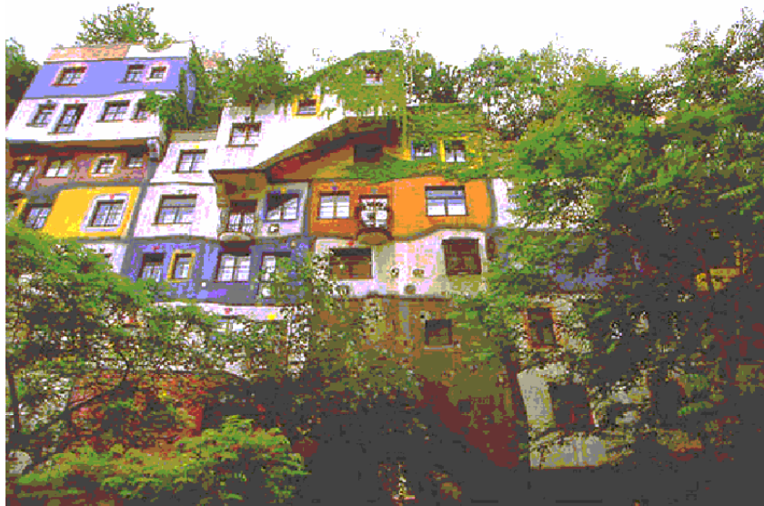
FIG. 36.- Casa Hundertwasser. Viena, vista posterior. 1985.
