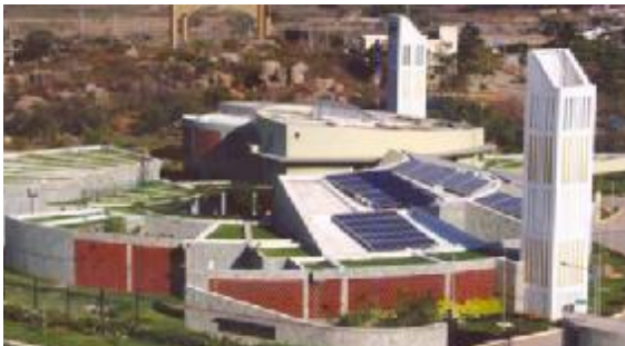
Figura 2.12. Edificio CII en Hyderabad de la India.
