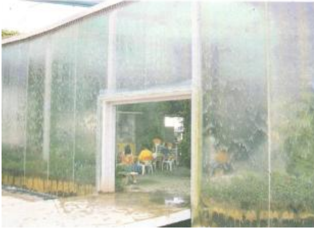
Figura 2.15. Pared de agua en la Avenida V.
