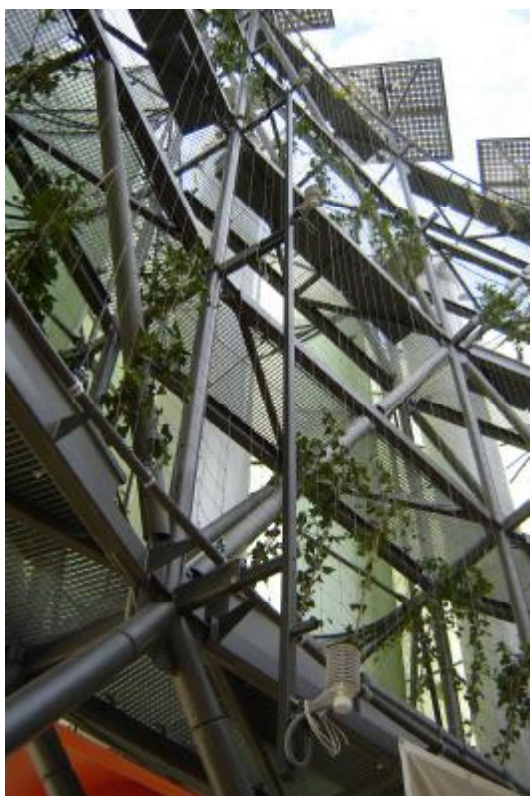
Figura 4.19. Varillas laterales donde se han instalado los sensores de las zonas norte y sur.
