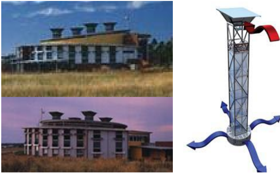
Figura 2.33. Torre de viento evaporativa del edificio de Aprendizaje.
