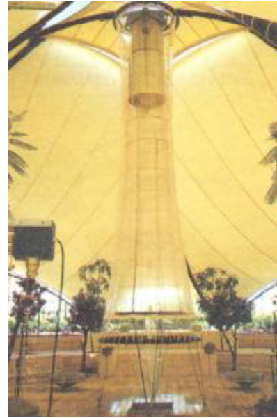
Figura 2.23. Torre de viento con ventilador en la Rotonda Bioclimática.
