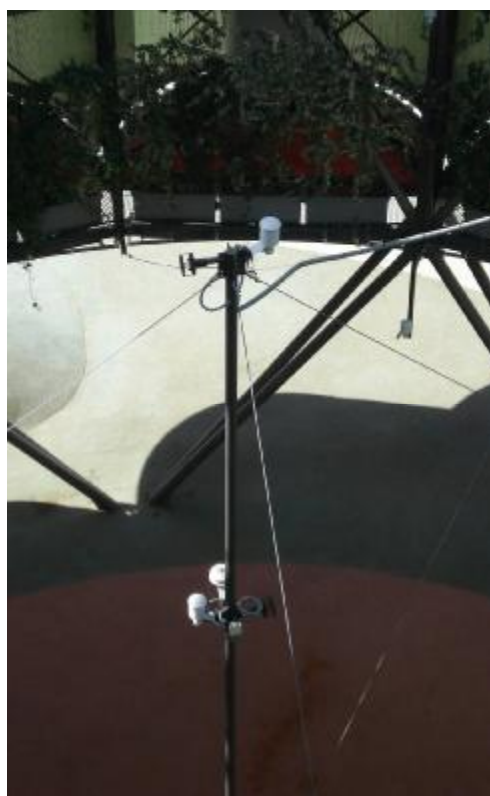
Figura 4.20. Varilla central donde se han instalado los sensores de la zona centro.
