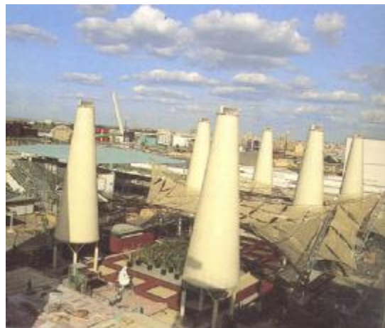
Figura 2.18. Torres de viento de la Avenida de Europa.
