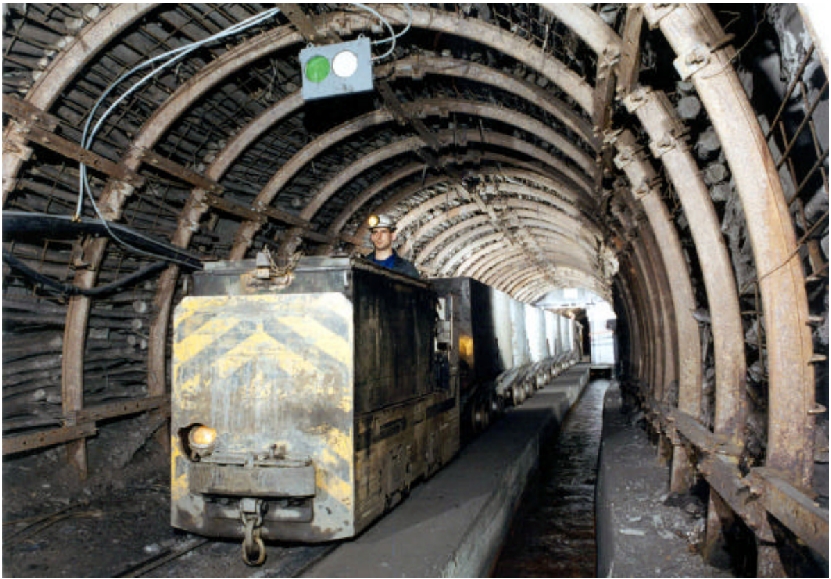
Máquina a baterías denominada "jaime" entrando con vagones por la galería general de la cota 0 del Grupo Carrasconte.
