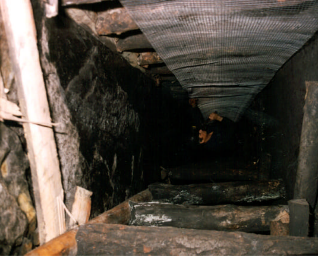
Montando malla metálica en capa inclinada para el relleno. - Foto 22 -
