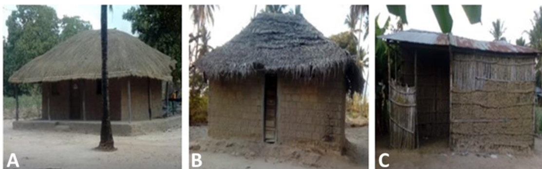
Figura 11. Viviendas características de áreas rurales de la provincia de Zambézia, Mozambique. (A y B) Viviendas construidas con ladrillos de adobe y cubierta vegetal de paja y hierba. (C) Vivienda construida con mampostería de barro y madera y techumbre de placa de zinc. Fuente: Aly Salimo Muadica (fotografías tomadas durante el trabajo de campo).
