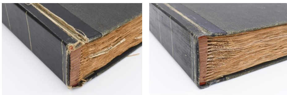
Estado de conservación de la bisagra externa antes y después del tratamiento.
