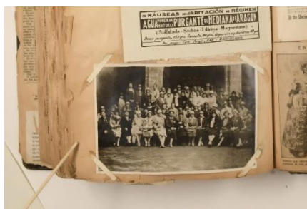
Fotografía original con esquineras.
