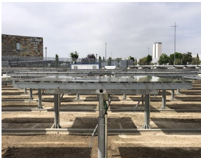
Figura 4.9. Foto mostrando como los heliostatos situados más lejos de la torre presentan una altura superior.
