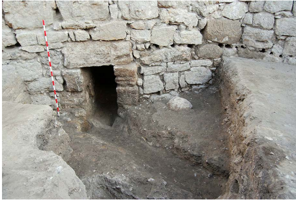
Fig. 7. Salida de la cloaca principal de la ciudad de época cesariana al exterior de la muralla. Fotografía: R. Cebrián.
