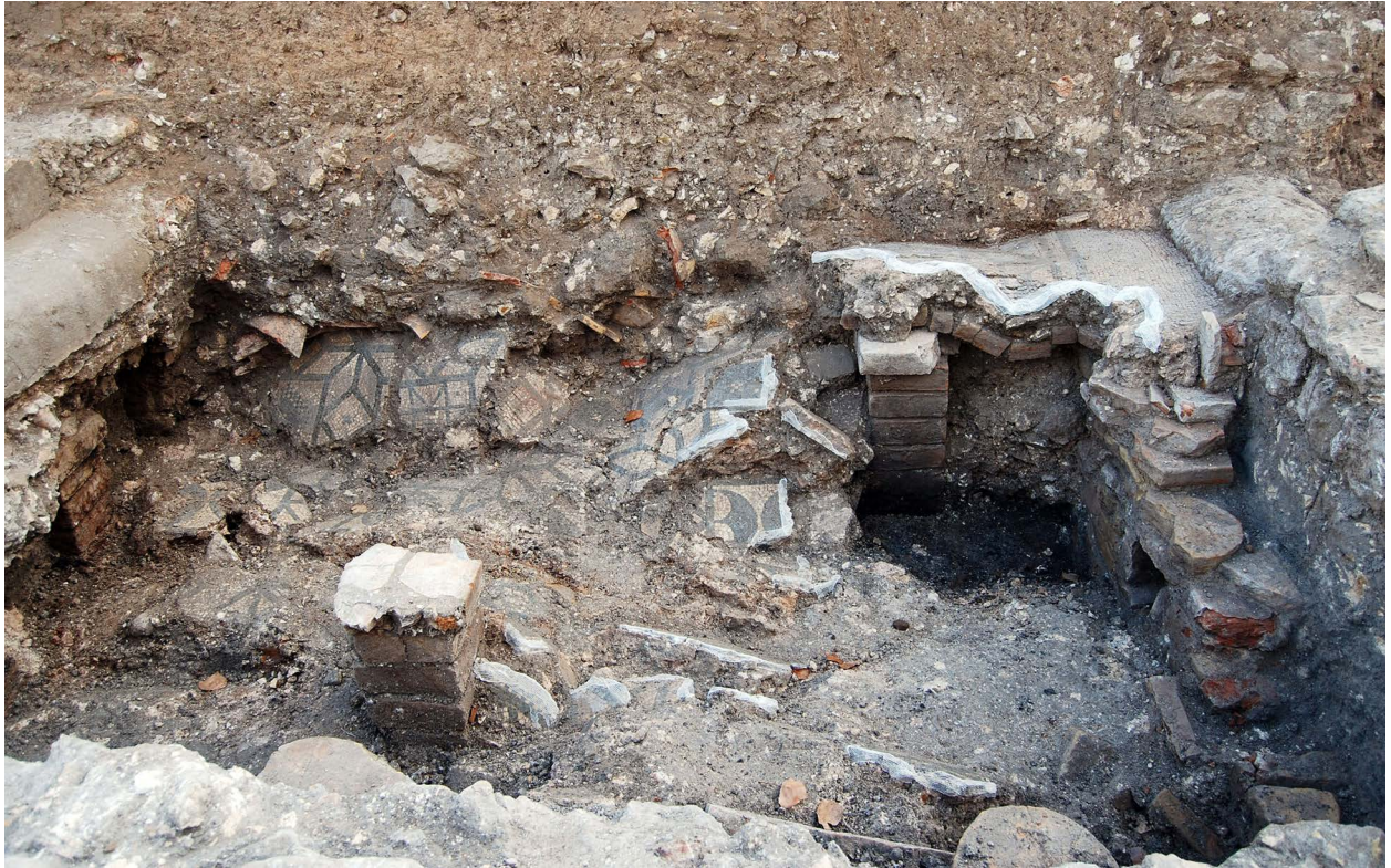
Fig. 12. Derrumbe del pavimento de mosaico del caldarium sobre su hipocausto de un edificio de baños integrante de la pars urbana de la villa de Casas de Luján en el territorio de Segobriga . Fotografía: R. Cebrián.
