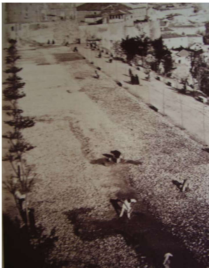
Foto 9. Trabajadores eventuales arreglando el Paseo del Salón.
