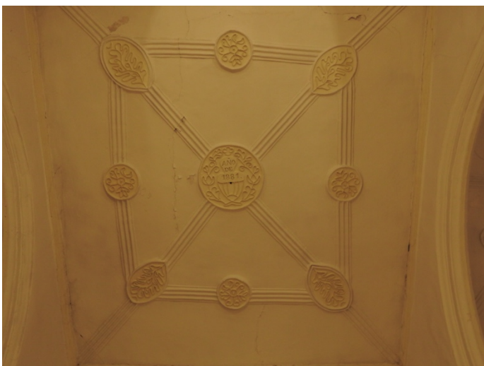
Fig. 6: Techo de la nave central.
