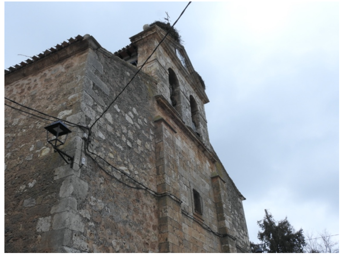
Fig. 4: Fachada de la Iglesia de Santa María.
