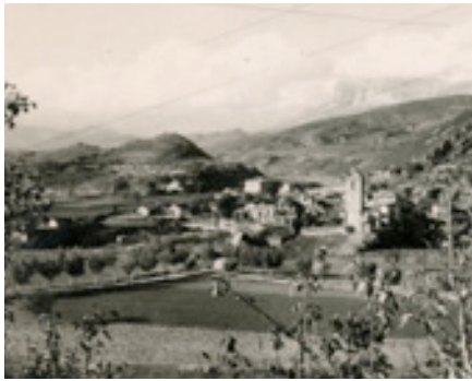
3 - Mediano antes de la inundación.
