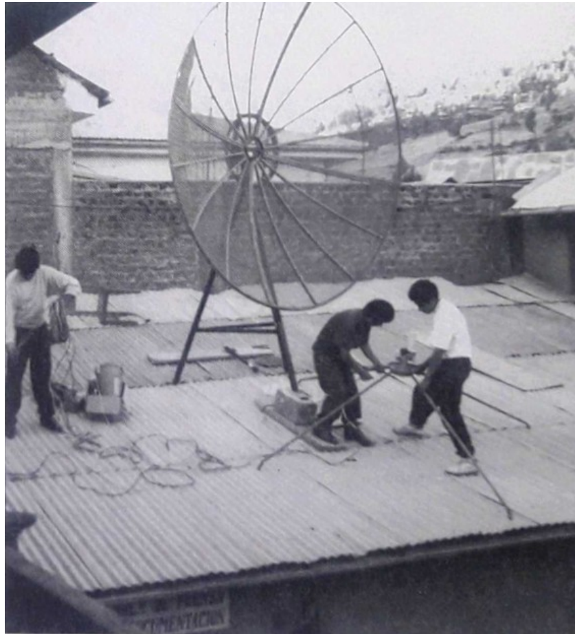
Figura 5: Instalación de la antena satelital en Radio Sicuani, Cusco, Perú. (ALER, 1998)
