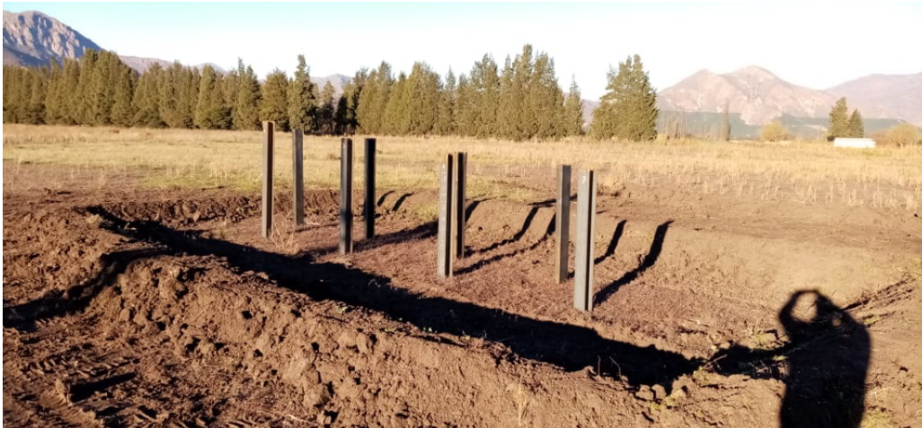
Figura 11 Aspecto de la “piscina” propuesta con los perfiles hincados en su interior. Fotografía cortesía de GEOINTEC
