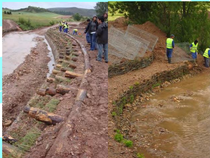
Figura 4. Estructuras de bioingeniería (empalizada krainer y fagina) usadas para estabilizar orillas (Riba de Saelices, Guadalajara; extraído de Mola et al. 2024 ).
