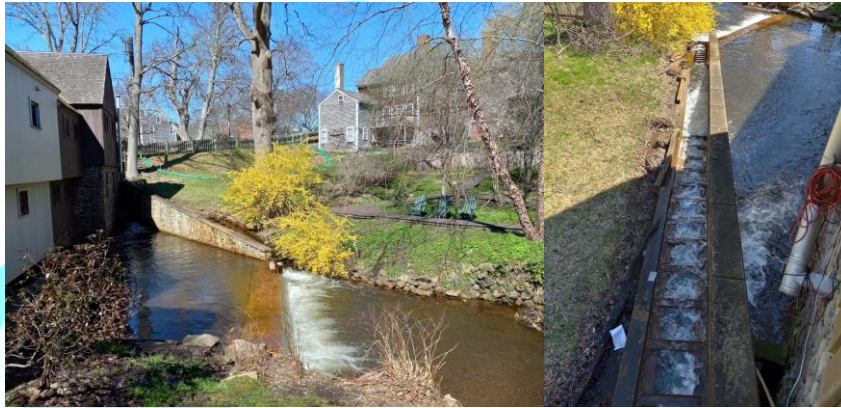
Figura 3. Escala para peces para favorecer la migración de los arenques río arriba para el desove en Plymouth (Massachusetts, EEUU). La escala salva el obstáculo creado por un antiguo molino hidráulico construido por las primeras familias colonas de Inglaterra que se establecieron en EEUU. Fotos de Verónica Cruz.
