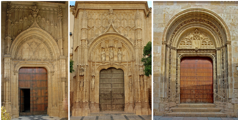
Fig. 9. De izquierda a derecha: portadas del monasterio jerónimo de Santa Marta, del hospital de San Sebastián y de la iglesia de San Andrés en Córdoba.
