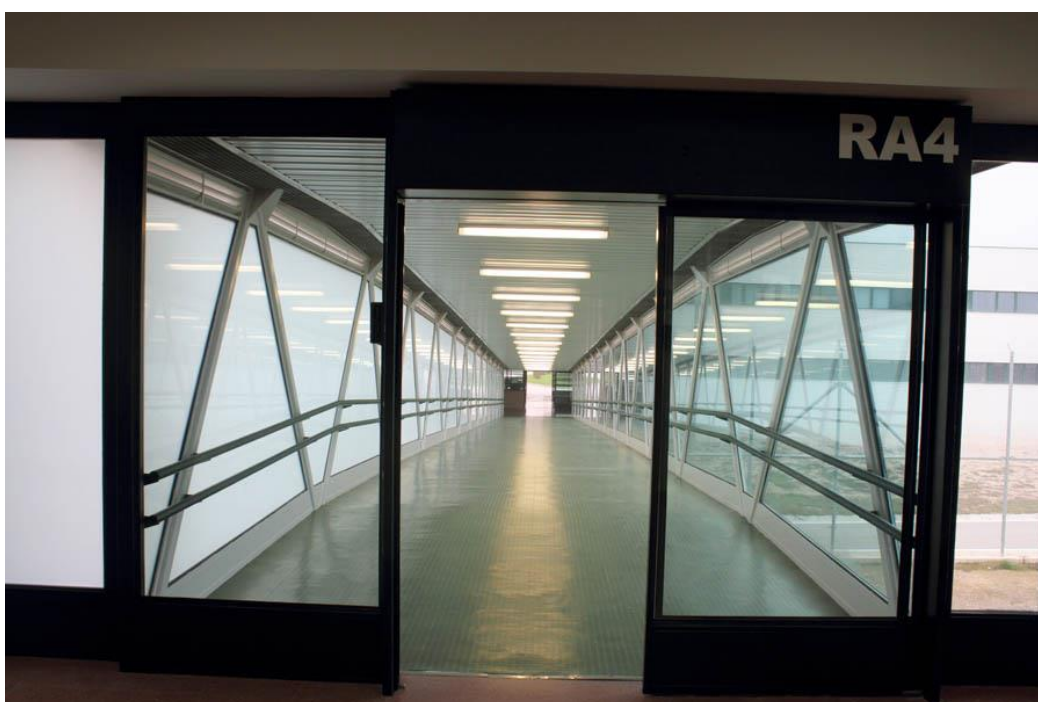
Figura 30. Pasarela del C.P. Málaga II (2011). Fuente: SIEPSE (2021)
