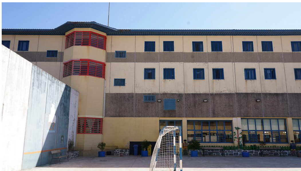
Figura 26. Vista de la fachada de un módulo desde su patio en el C.P. A Lama. Las ventanas azules son de las celdas, mientras que las rojas son de las garitas de los funcionarios, con visión también del módulo contiguo. Fuente: Puga y Patxot (2018)
