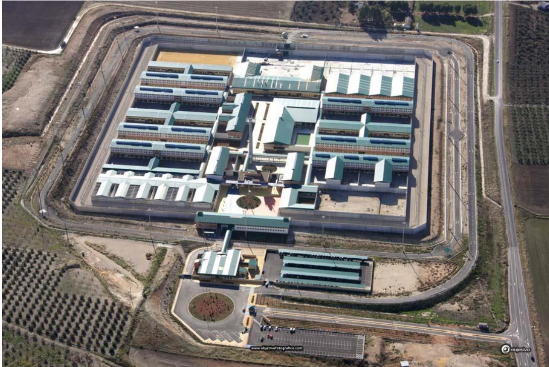
Figura 16. Centro penitenciario Sevilla II (Morón de la Frontera). Fuente: SIEPSE (2021)
