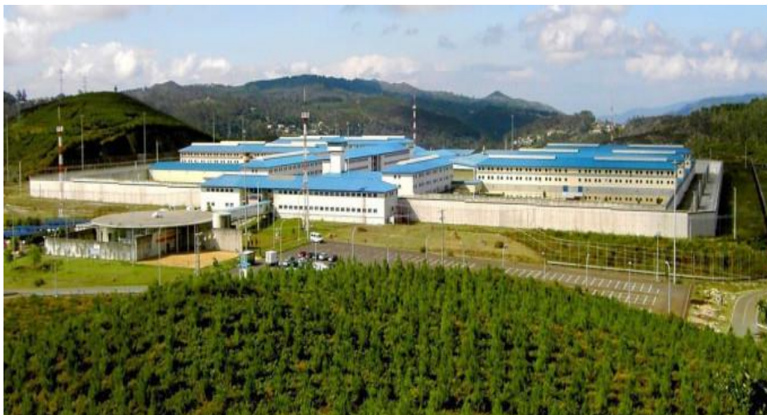
Figura 15. Centro penitenciario de A Lama (Pontevedra), ejemplo de centro-tipo construido en los 90.
