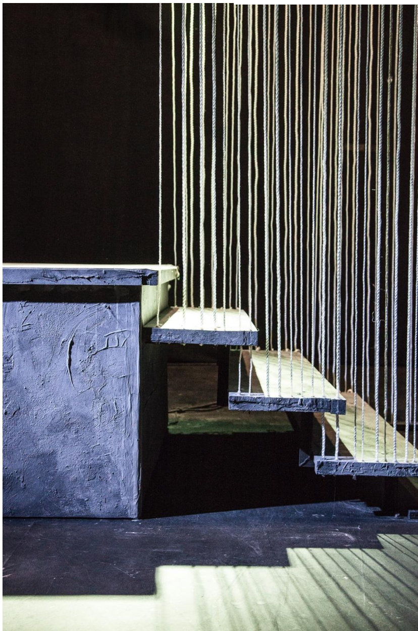
Escalera al aire terminada
