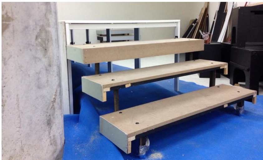
Escalera al aire en construcción
