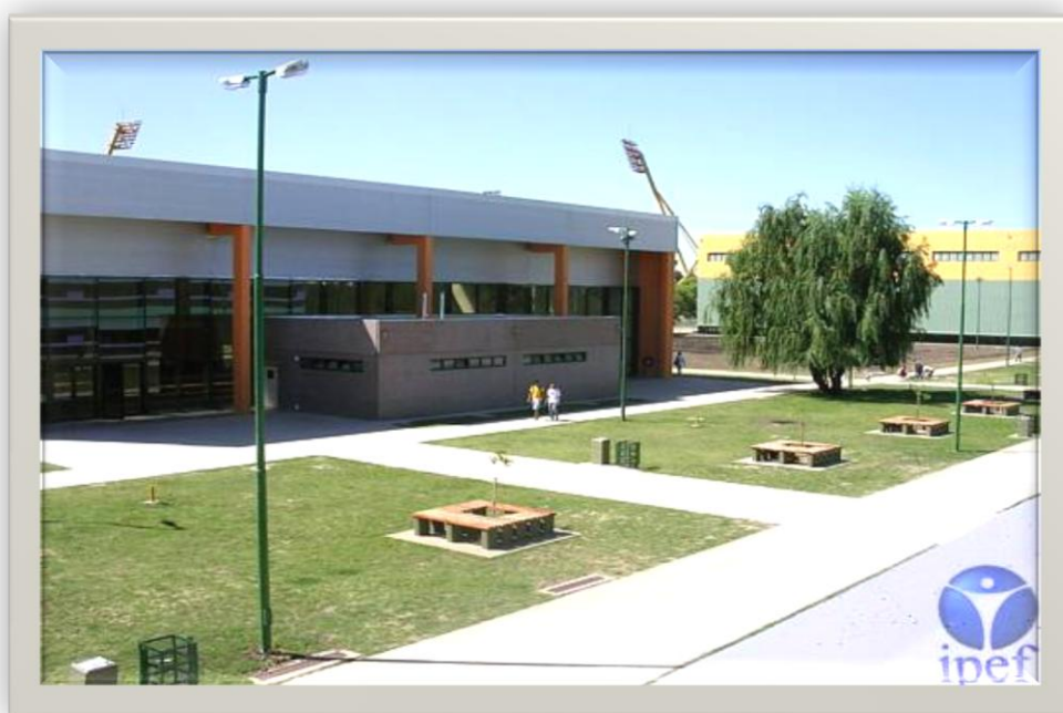
Foto N° 39: patio interno del nuevo edificio del IPEF, 2006. Fuente: sitio web www.ipef.edu.ar
