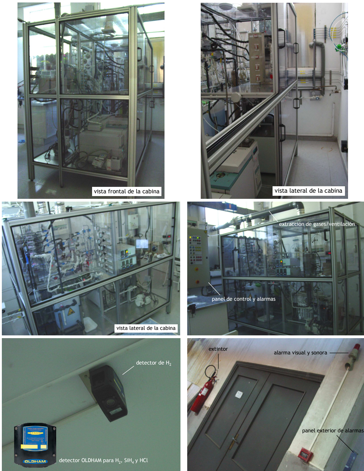
Figura 2.29. Imágenes de la cabina ventilada en la que se ubicaban los equipos, así como de los dispositivos de seguridad implementados (detectores, extintor, paneles de control y alarmas visuales y sonoras).
