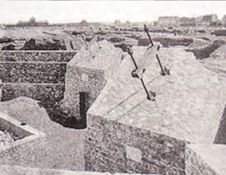
Abajo: Cimientos de la Torre Eiffel.
