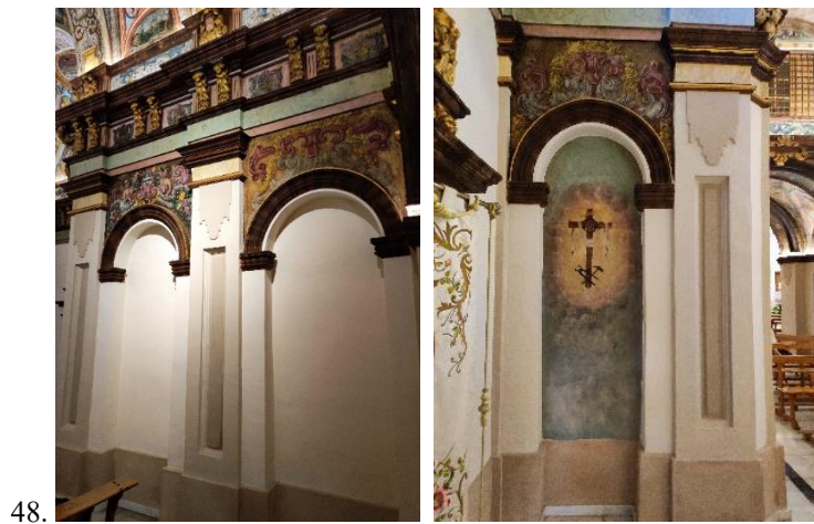
Figura 48. Hornacinas del lado de la Epístola en la nave principal y en el transepto.
