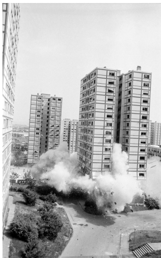
Demolición de la torre 6 de Les Minguettes en Vénissieux el 9 de junio de 1983 (Bibliothèque municipale de Lyon, 2011).
