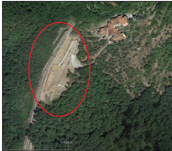
Figura 8. Imagen satélite de las obras de estabilización de la ladera junto a las vías férreas
