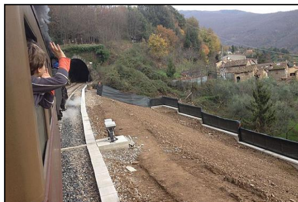
Figura 14. Momento del tren a su paso por la zona deslizada
