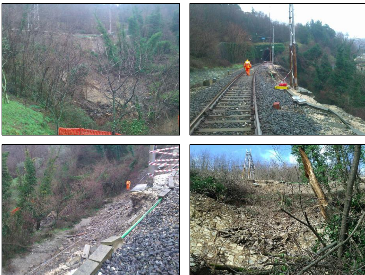
Figura 10. Imágenes del deslizamiento en la línea Porrettana poco después de producirse
