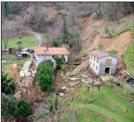
Figura 19. Las dos viviendas afectadas por el deslizamiento
