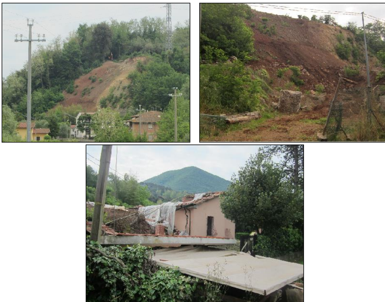
Figura 29. Imágenes de la situación actual del deslizamiento. Se aprecian pocos cambios con respecto a 2014, la vivienda sigue todavía en pie y está prohibido acceder a ella
