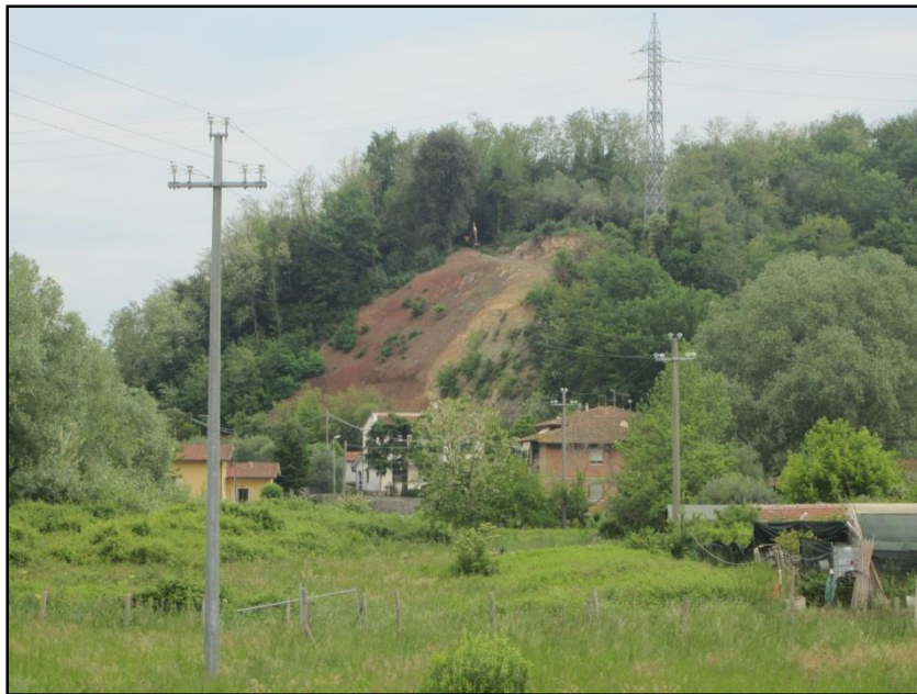
Figura 26. Vista de la fuerte pendiente de la ladera deslizada
