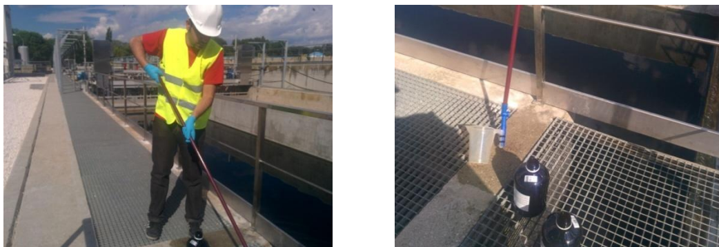
Figura 45: Toma de la segunda muestra de agua de la Estación Depuradora de Aguas Residuales.
