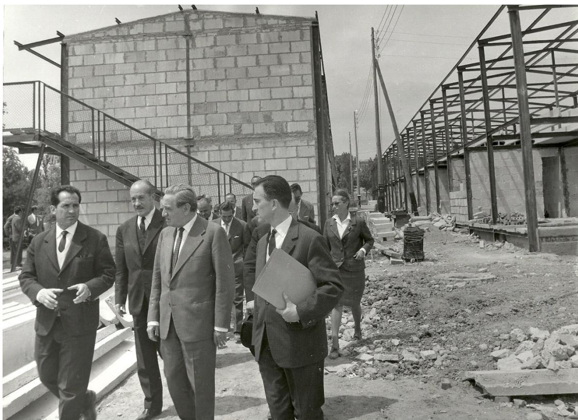
A pie de obra.
