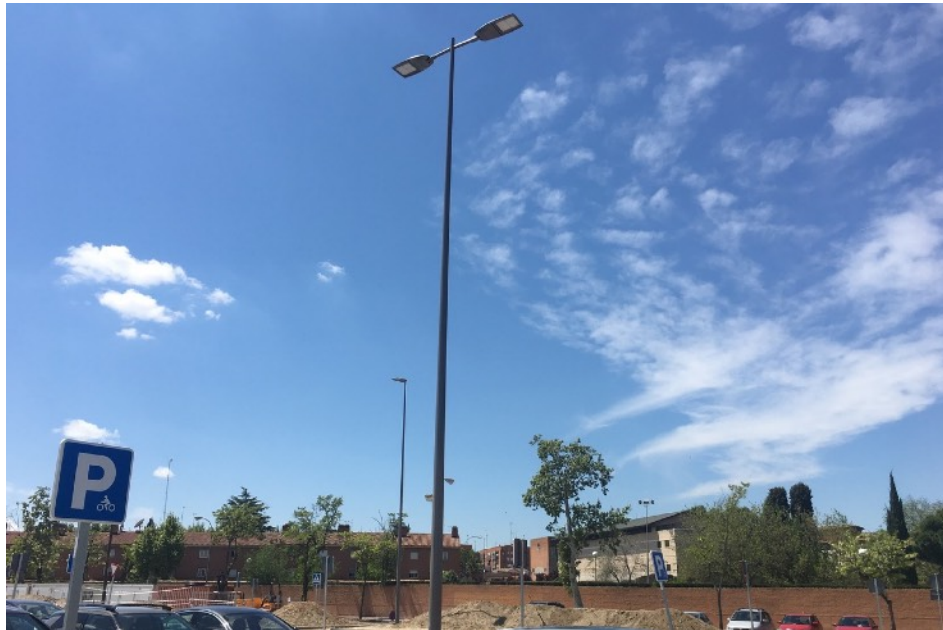
Figura 3.26. Ejemplo de emplazamiento de cámara IP
