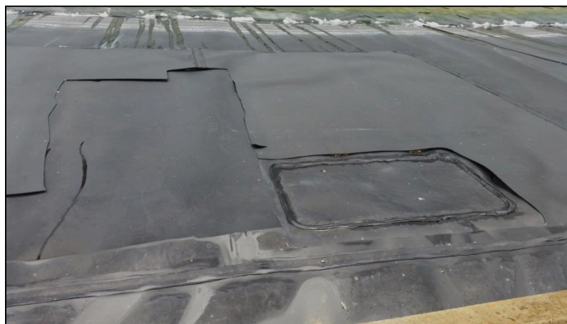
Figura 3.10. Probetario de geomembrana de PEAD instalado en la zona de coronación del embalse. Se observa que también se ha realizado la extracción de una muestra de la geomembrana situada debajo del probetario, que ha tenido que ser reemplazada
