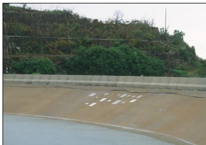
Figura 3.8. Zona de extracción de muestras de la geomembrana de PVC-P en coronación del embalse de Buen Paso
