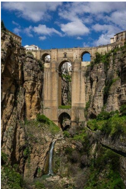
Puente Nuevo de Ronda
