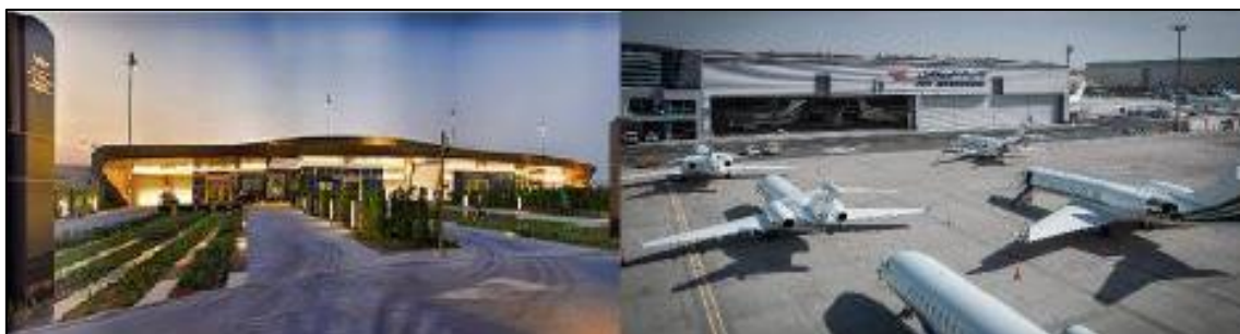
Figura 43: Terminal ejecutiva del aeropuerto de Dubái (Emiratos Árabes)
