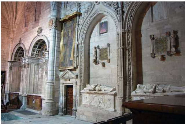
Figura 141: Interior de la Capilla de los Caballeros, Antonio Flórez, entre 1520 y 1531, Catedral de Cuenca. La casa de Clío.
