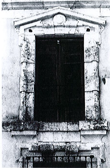
Fig. 2.- Tipos de pátinas sobre rocas calcáreas; biológicas (negras) e históricas (anaranjadas). Types of patina over calcium based rocks: biological (black) and historical (orange). Iglesia-Palacio de Goyeneche, Nuevo Baztán, Madrid (Foto R. Fort).
