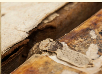
Fig. 40. Pérdida de funcionalidad del enlace, BH INC FL- 12. ©J. Marquerie 2015
