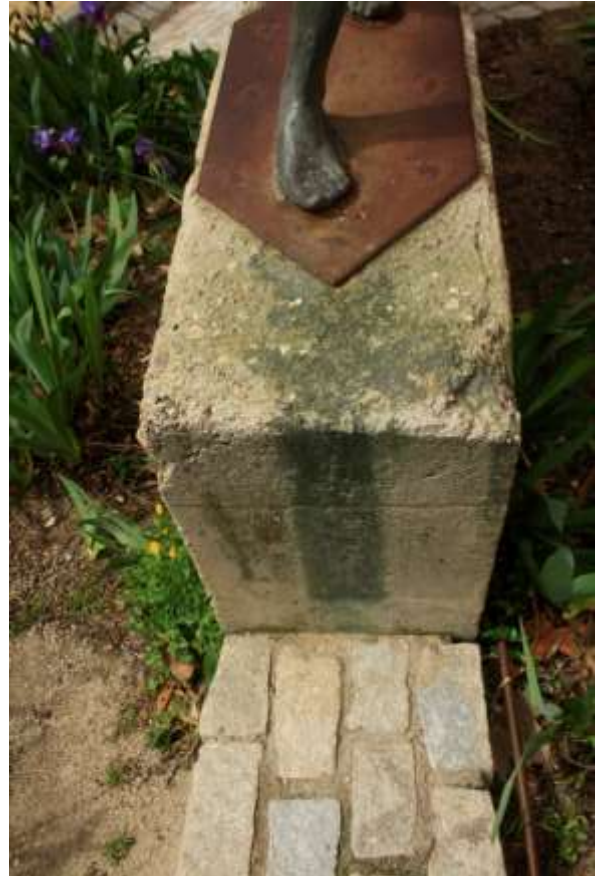
Manchas y depósitos sobre el pedestal.
