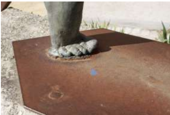
Mancha de pintura en la base de acero Cor-ten.
