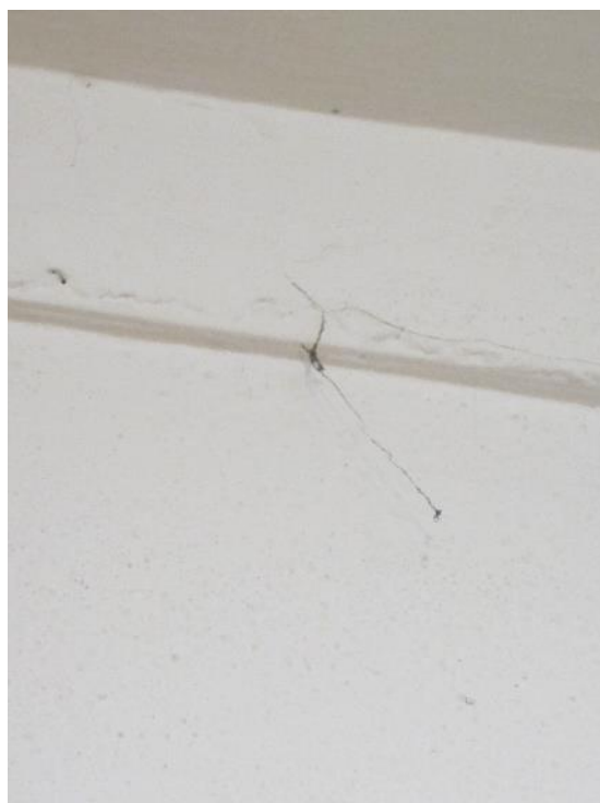
Figuras 26 y 27. Detalle de los procesos de cristalización de sales y de una de las telarañas encontradas en el taller. Fotografías realizadas por la autora.
