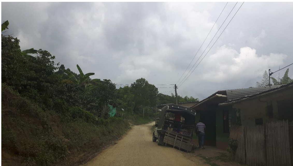
Carretera de acceso a la Vereda de Los Monos, Caldonó (Cauca). PABLO GRACIA
