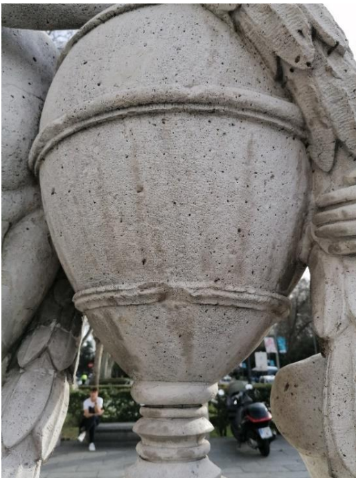
Fig. 29: Manchas oscurecidas causadas por la humedad.
