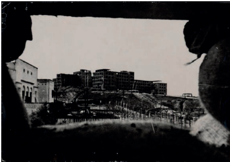
Figura 68. (Biblioteca Nacional de España). Vista del Hospital Clínico desde un parapeto republicano en la Colonia Metropolitana.
