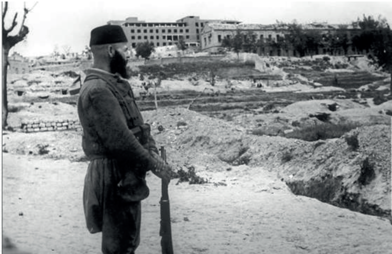
Figura 72. (EFE). Soldado marroquí en su puesto de vigilancia en la ladera oeste del Cerro del Pimiento, con el Hospital Clínico al fondo y restos del Asilo de Santa Cristina en primer plano.
