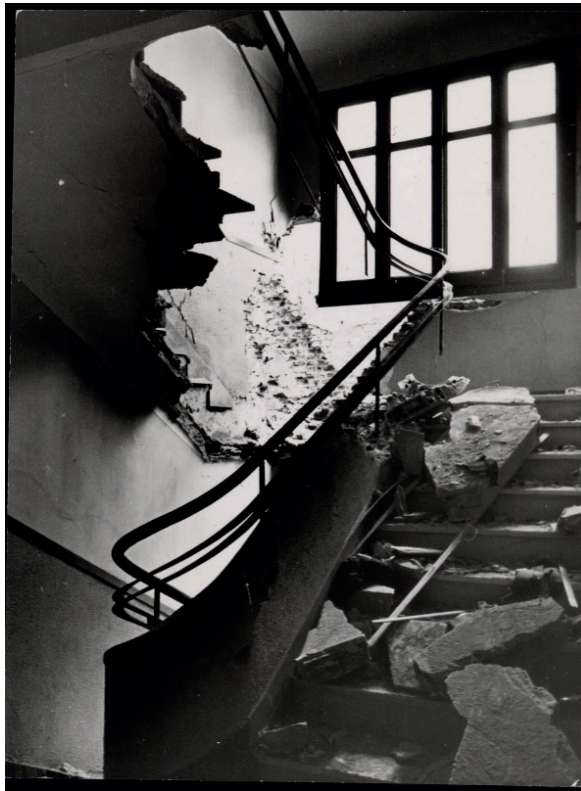
Figura 65. (Biblioteca Nacional de España). Escaleras interiores del Hospital Clínico.
