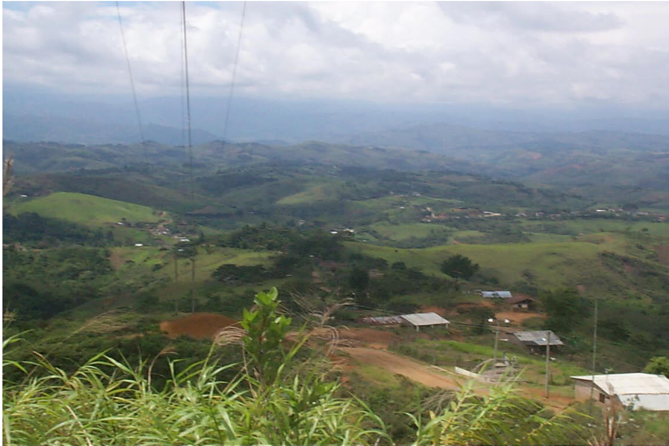
Figura 19. Subcuenca del río Quinamayó, vista panorámica tomada cerca del nacimiento de la quebrada La Chapa, frente a la vereda Chapa a 1655 msnm. Al fondo en la parte superior izquierda de la foto está el cerro Munchique tapado por las nubes.
