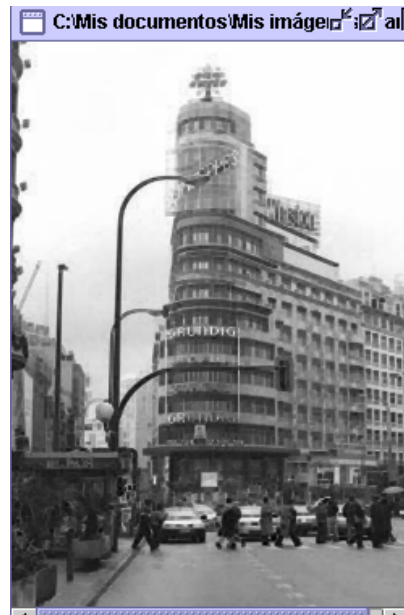
Efecto de la erosión.
