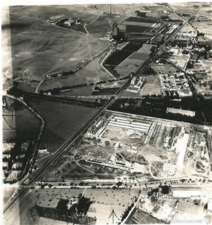
Fig. 3. Construcción de la fábrica Roca junto a las vías ferroviarias (septiembre de 1958). Fuente: Archivo Servicios Aéreos Norte. www.todocoleccion.net
