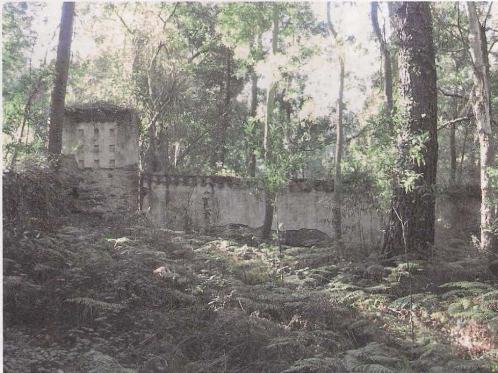
Figura 7. Detalle de la esquina S-E. del recinto funerario.
