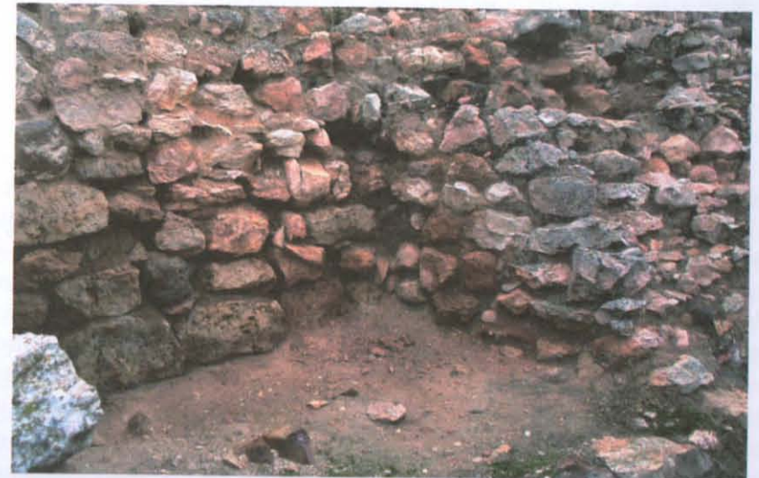
Fig. 11. Zona basal de la muralla ibérica con inicio de uno de los bastiones (dcha.).
