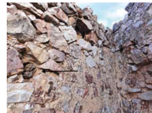
Muro interior que conserva un mechinal con fragmento de rollizo de fresno sometido a análisis, señalado con una flecha.
