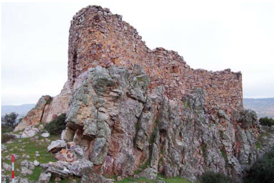
Alzado exterior de la muralla de la fortificación roquera de los Baños del Cristo.
