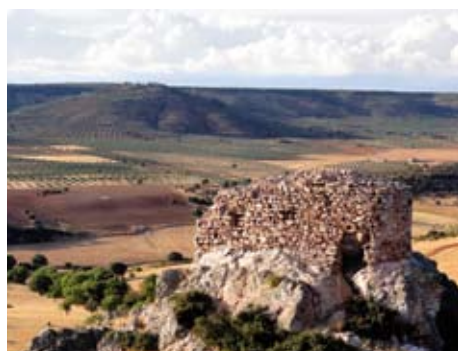
Control visual del Castillo de los Baños del Cristo.
