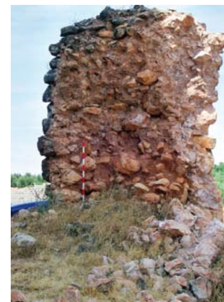
Cubo de la antemuralla del Castillo de Terrinches antes de su restauración.
