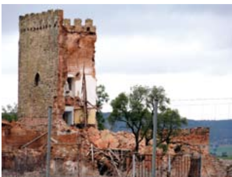
Torre Gorgojí en 2012, tras su desmoronamiento parcial.
