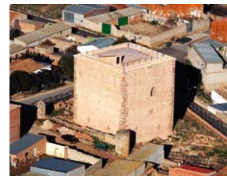
Vista aérea de la Torre del Homenaje del Castillo de Terrinches. Se aprecia que la trama urbana ha invadido el solar ocupado anteriormente por el castillo. Foto: SAF.
