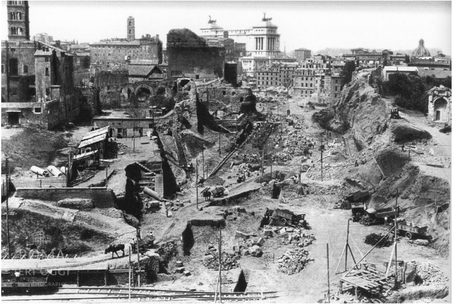
66. Via dei Fori Imperiali in costruzione, 1932
