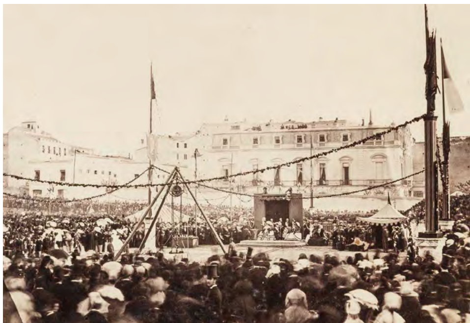
Fig. 51. Conde de LIPA (fotógrafo): Colocación de la primera piedra de la Biblioteca y Museo Nacional, Madrid, Biblioteca Nacional, 1865.
