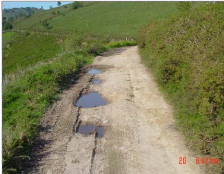
Vial con firme REGULAR, zona puntual de baches
