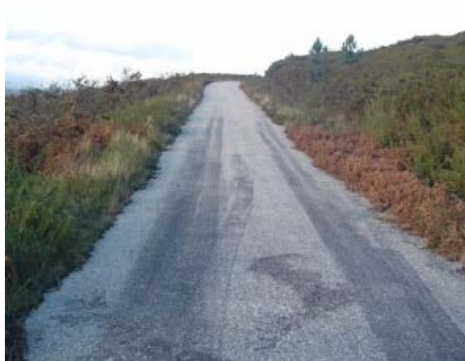
Pista asfaltada. Estado de firme BUENO
