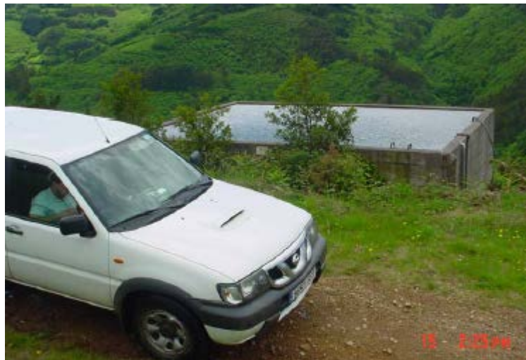
PUNTO DE AGUA de lucha contra incendios forestales
