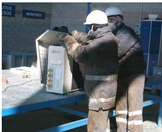
Ilustración 103. Desmontaje de carcasas
