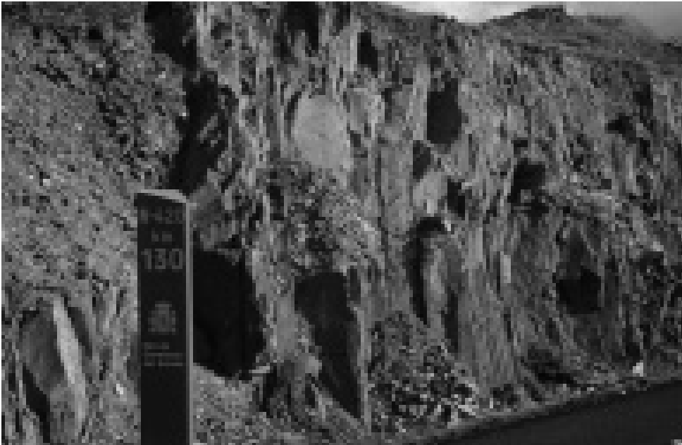
Fotografía 3: Corte de carretera con una buena exposición de las turbiditas del Alcudense Inferior en el Km 130 de la N-420.
