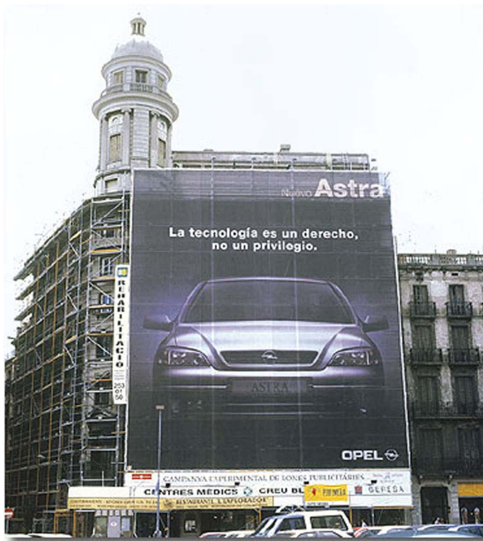
Impresión de inyección de tinta sobre una lona perforada de 425 m2. C/ Pelayo, 40 Barcelona, realizado por Sanca, Servicios generales a la publicidad 9
