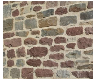
Figura 3. Muro de mampostería con mortero cal hidráulica natural NHL5. Imagen tomada de:
