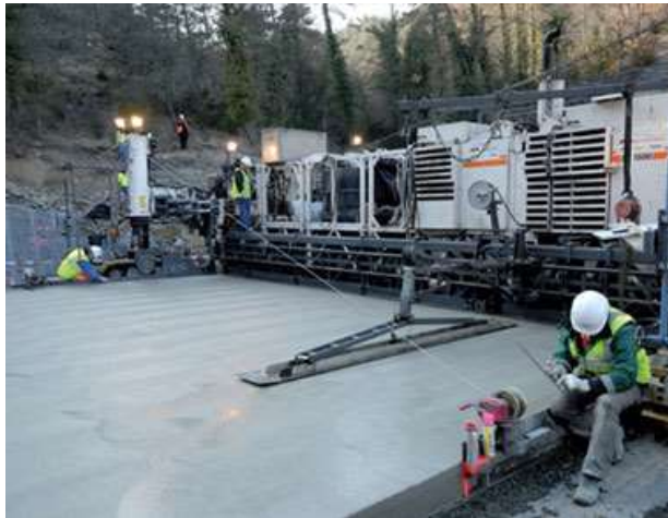
Figura 5. Pavimentación mecanizada a base de mortero de cemento clásico Portland (AC). Imagen tomada de http://www.imcyc.com/revistacyt/jul10/pavimentos.htm
