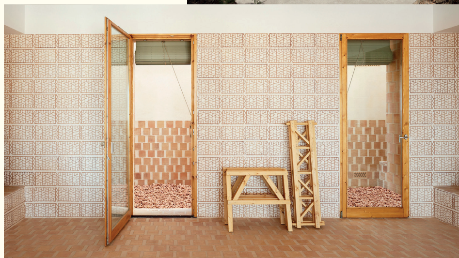
Can Picafort, Santa Margalida, Majorque, Espagne, 2017. Réhabilitation d'une maison de 360 m 2 en quatre appartements touristiques. Les architectes ont utilisé la tranche des briques en terre cuite pour dessiner les motifs muraux. Renovation of a 360-sq.metre house into four tourist dwellings. The architects have used the terracotta bricks' edge to draw the wall patterns.
